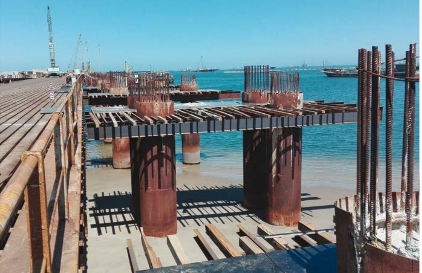
TRABAJOS DE CONSTRUCCIÓN DEL VIADUCTO Y DE LA ZONA DE AMARRE
