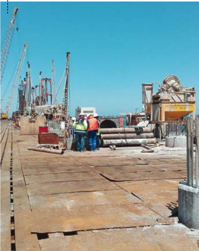
TRABAJOS DE CONSTRUCCIÓN
