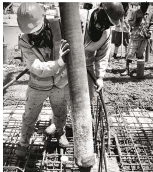
HORMIGONADO DE LOSA
