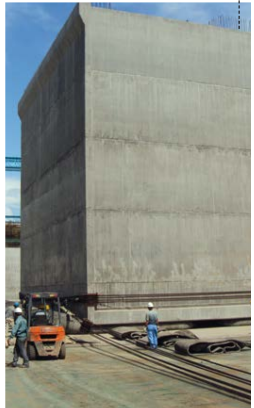
PREFABRICACIÓN DE LOS VOLUMENES DE HORMIGÓN
