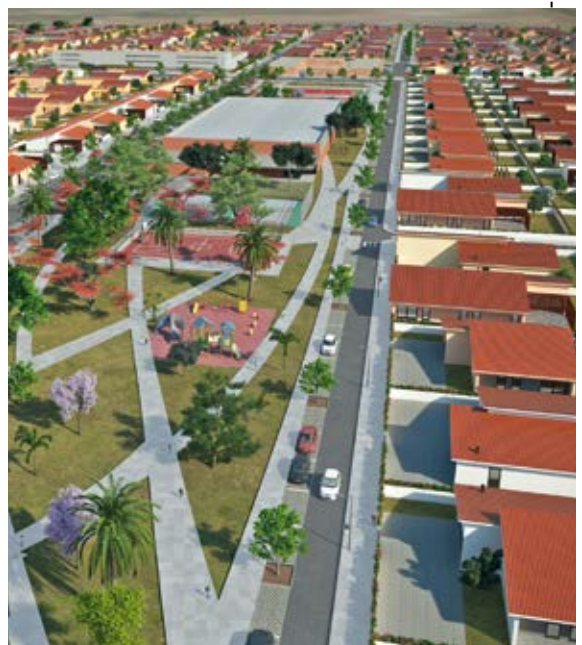
VISTA AÉREA PARCIAL
