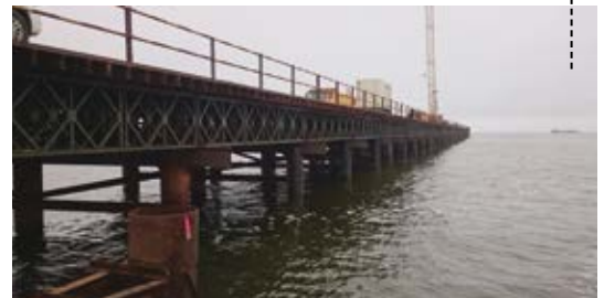
TRABAJOS DE CONSTRUCCIÓN DEL VIADUCTO Y DE LA ZONA DE AMARRE
