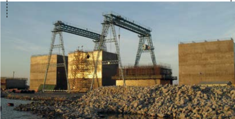
PREFABRICACIÓN DE LOS VOLUMENES DE HORMIGÓN
