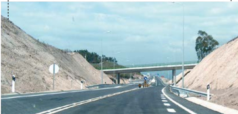
PUESTA A DISTINTO NIVEL DE LA VARIANTE Y DE LA EN 321-1 EN LAS PROXIMIDADES DE LAMEIRÃO
